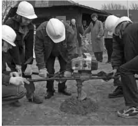
1 e paal voor het woonhuis wordt in de grond geschroefd (foto: Ageeth Koning)
